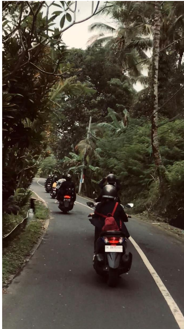
Gambar 3 Kondisi jalan raya menuju desa Buahman
